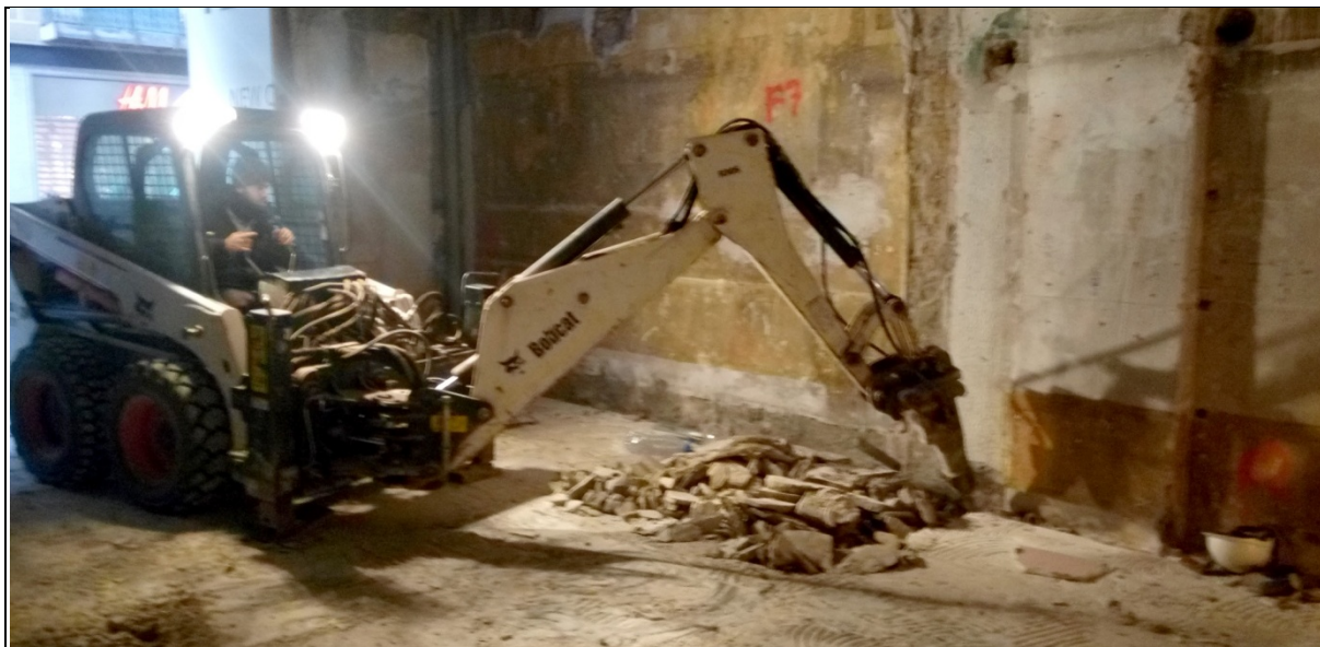
Vista dels treballs duts a terme amb mitjans mecànics.
