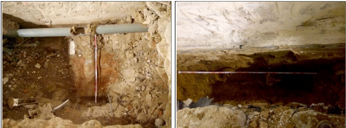
A l'esquerra, vista del clavegueram localitzat en el sondeig S2. A la dreta, vista de la riosta R2.
