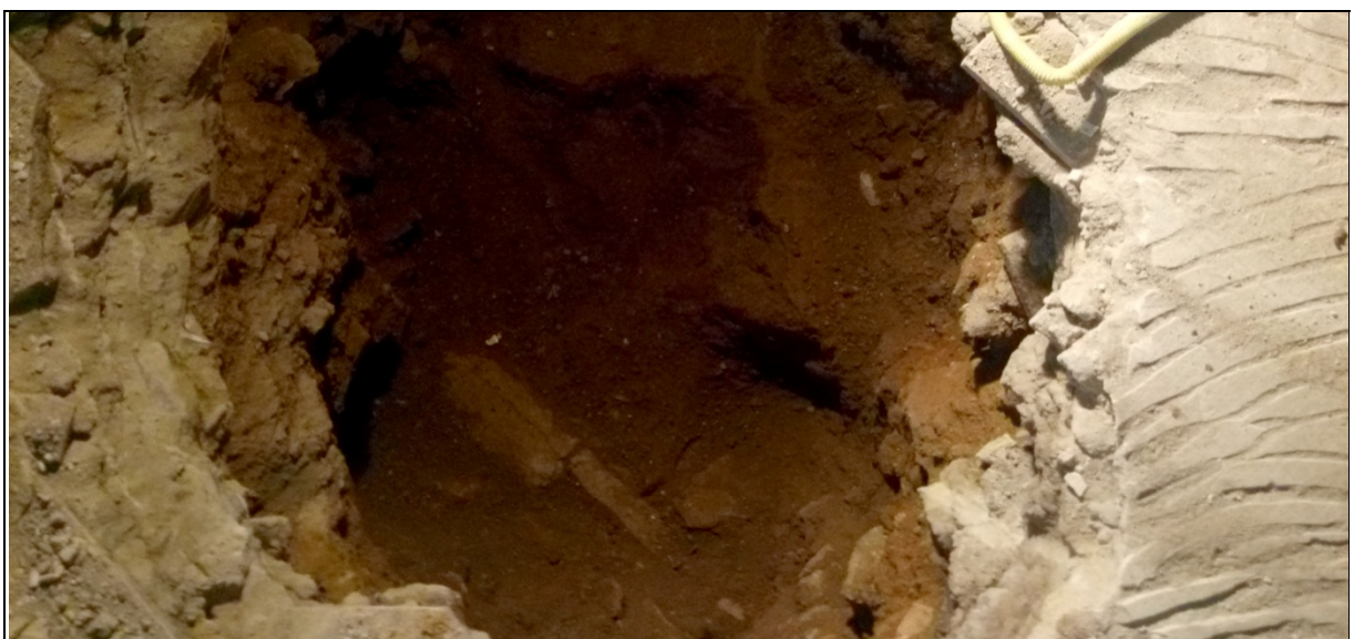
Vista de la canalització de formigó (UE 49) a l'interior del sondeig S4.
