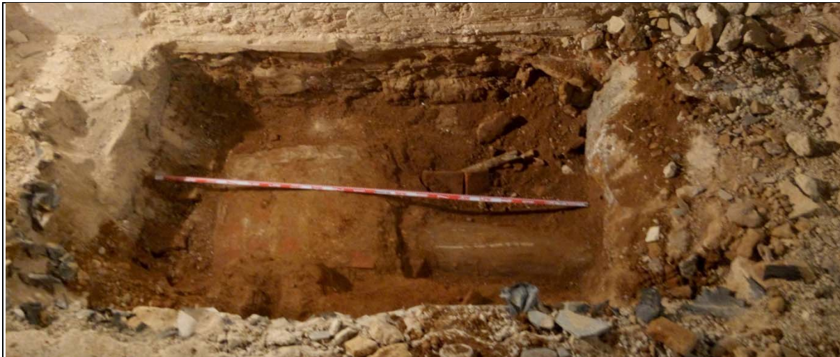
Vista del sistema de clavegueram actual (UE 07, UE 08 i UE 12) localitzat a l'interior del sondeig S1.
